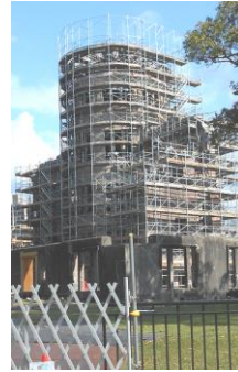
原爆ドームは改修中でした。
